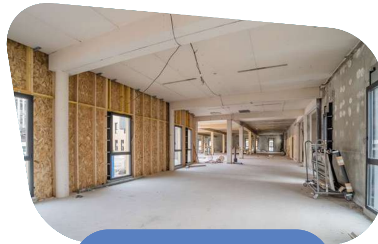
Réhabilitation du futur siège de l'Agglomération
